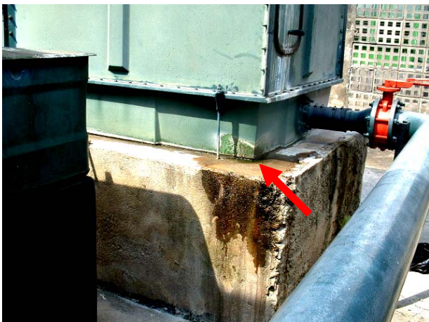
Foto 4 e 5: Detalhes de torres de arrefecimento de sistemas de ar condicionado com ausência de aletas, o que provoca perda de carga no sistema. Observam-se, também, vazamentos.
