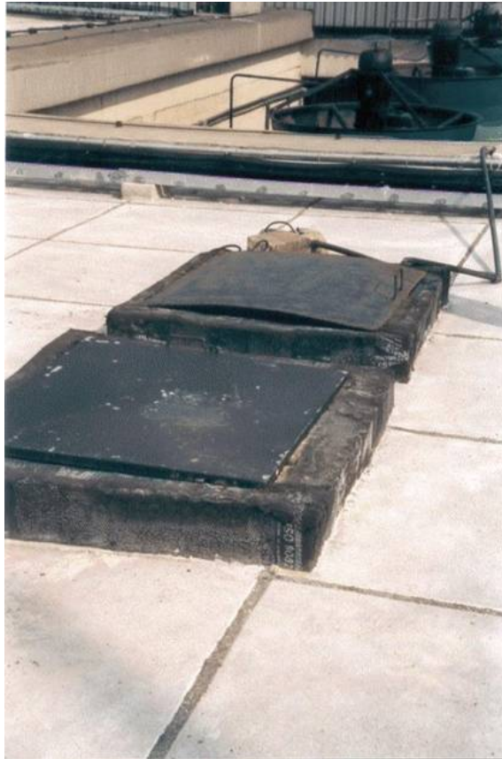
Foto 13: Outras tampas de reservatório superior de água potável em ferro. As tampas estão corroídas, e não oferecem condições de fechamento que impeçam a contaminação da água armazenada.
