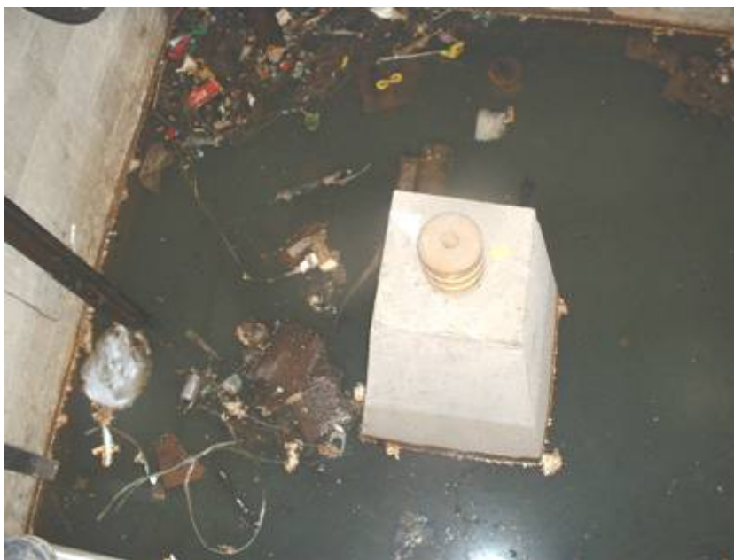
Foto 17: Detalhe de poço de elevador com infiltrações e sujeira. Verifica-se a ausência de fiscalização da Manutenção sobre as atividades das terceirizadas mantenedoras do sistema de elevadores, já que a limpeza e inspeções dos poços, normalmente, é executada por empresas especializadas.
