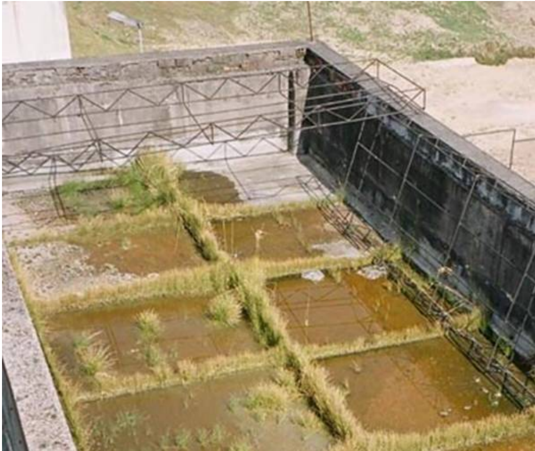
Foto 11: vista de laje de cobertura com vegetação formada nas juntas de trabalho da proteção mecânica do sistema de impermeabilização, devido a ausência de procedimentos de limpeza do local. Observam-se, também, restos de estruturas metalizas no local, sem uso.
