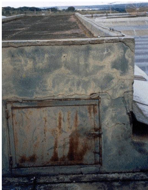
Foto 23: Detalhe de revestimento em argamassa deteriorado com formações de fissuras higrotérmicas devido às infiltrações de água e a ausência de manutenção no sistema de pintura, bem como ausência de rufos pingadeiras superiores.
