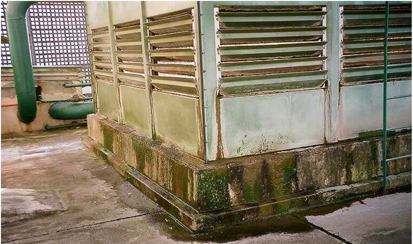
Foto 3: Vista parcial da base de concreto armado de torres de arrefecimento de água de condensação do sistema de ar condicionado. Observa-se a ausência de limpeza, pintura, bem como problemas relacionados a vazamentos da torres, deficiências de tratamento químico da água de condensação, etc.
