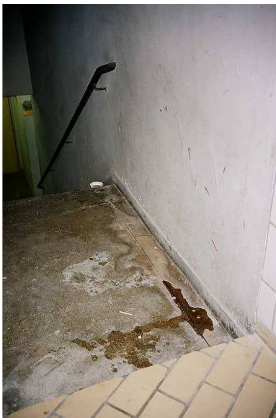
Foto 20: Vista de uma escada de emergência com urina, sujeiras e revestimentos deteriorados, sem pintura recente.
