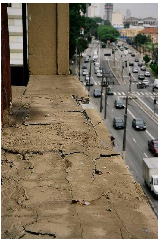
Foto 24: Detalhe de respaldos em concreto armados em fachadas. Observam-se a deterioração do concreto com corrosão de armadura, formações de fissuras e perda do monolitismo. Há risco de queda nas calçadas, junto ao passeio público.
