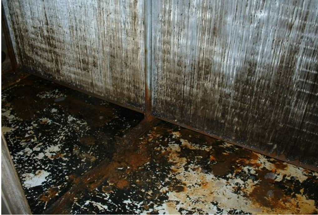
Foto 15: Vista de uma serpentina de fan coil de alvenaria em sistema de ar condicionado central com as seguintes falhas: (i) corrosão dos requadros metálicos; (ii) bandeja metálica corroída e sem limpeza e tratamento da água de condensação; (iii) serpentina suja, sem limpeza, etc. Este equipamentos não atende as determinações da ANVISA quanto ao Programa de Manutenção e Operação de Sistema de Ar Condicionado.
