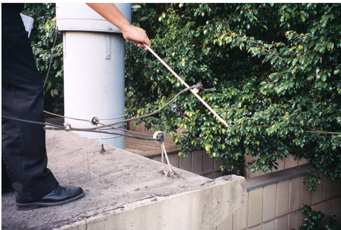
Foto 18: Vista de cabo do sistema de pára-raios solto, sem conexão com a malha. Há risco de centelhamento quando da descarga atmosférica. Observa-se a presença de vegetação próxima (árvores) o que aumenta os riscos de incêndio.
