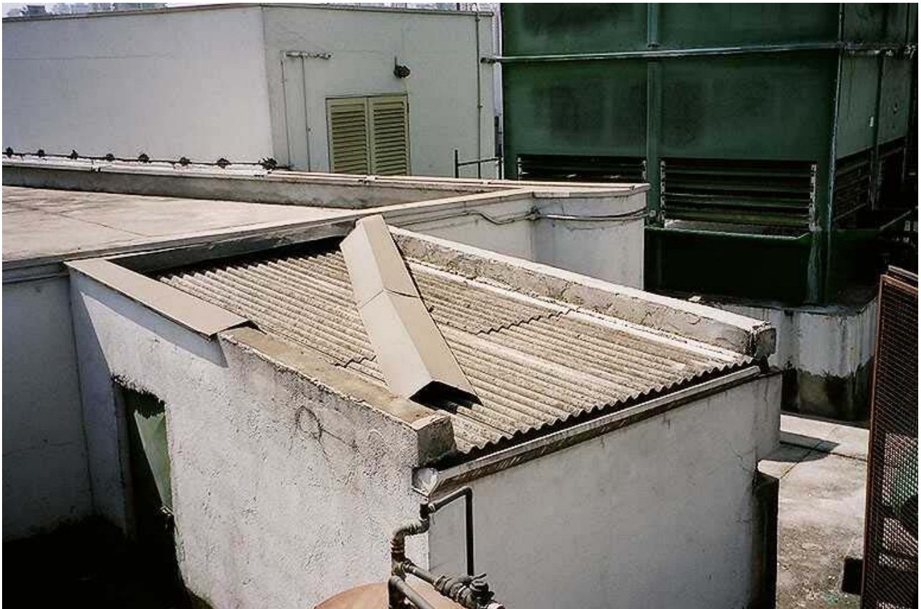
Foto 1: Vista de rufo solto sobre telhado de uma casa de máquinas em cobertura. Detalhe das fissuras higroscópicas formadas devido à incidência das infiltrações de água no revestimento. A pintura está deteriorada, assim como a argamassa.
