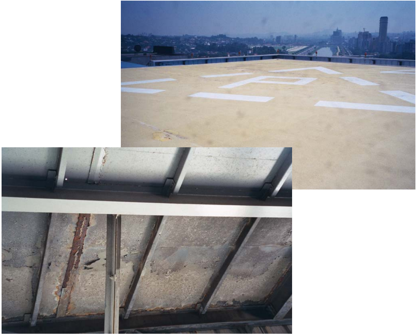
Foto 25 e 26: Vista de um heliponto com estrutura metálica. Detalhe para a corrosão das chapas metálicas.
