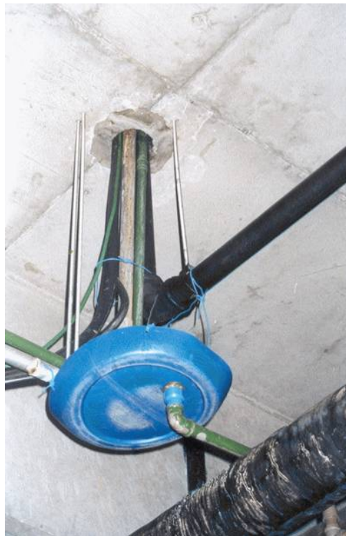
Foto 22: Detalhe de “prato plástico” instalado junto as tubulações elétricas e hidráulicas, para conter infiltrações.
