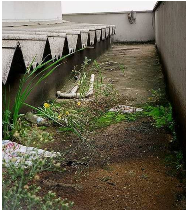
Foto 16: Vista parcial de cobertura com ausência de limpezas, proliferação de vegetações, acúmulo de sujidades em coletores pluviais (ralos) e deterioração de revestimentos de paredes e da proteção mecânica do sistema de impermeabilização existente.
