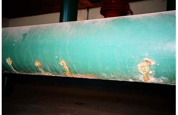
Fotos 6 e 7: Detalhe de tubulações de água corroídas e com vazamentos
