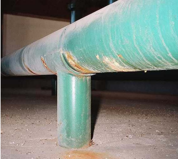
Fotos 6 e 7: Detalhe de tubulações de água corroídas e com vazamentos
