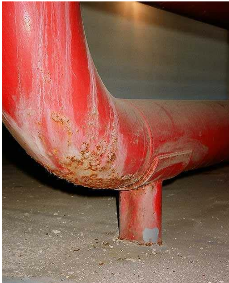
Foto 8: Detalhe tubulação de incêndio corroída
