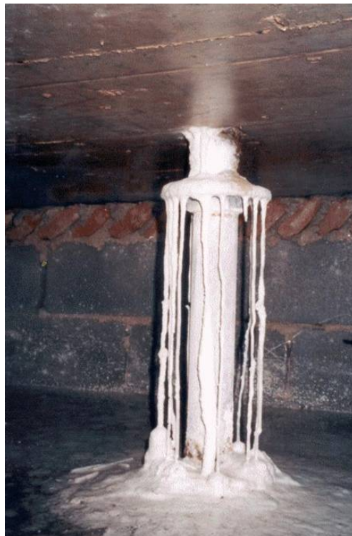
Foto 14: Vista de tubulação junto a laje de fundo de reservatório de água potável com vazamentos e infiltrações.
