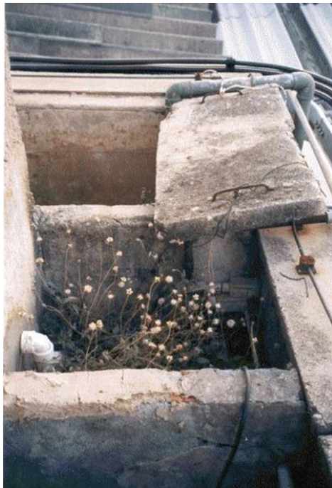
Foto 12: Vista de tampas de reservatórios superiores de água potável com presença de vegetação, tampas em concreto deteriorado e sem vedação adequada, tubulações de abastecimento corroídas e instaladas em local inadequado, impedindo o fechamento correto das tampas.
