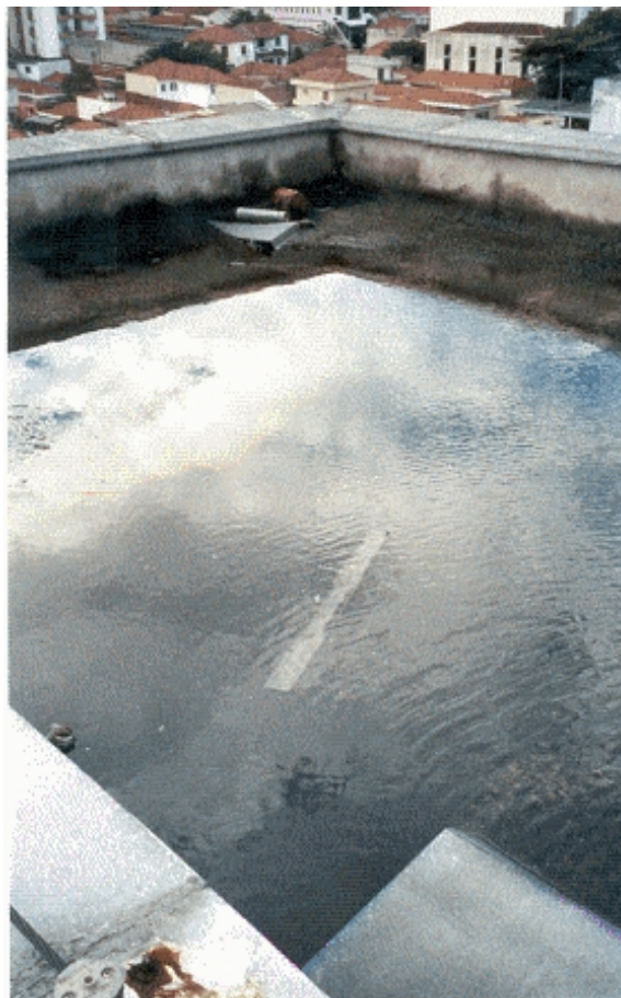
Foto 10: Acúmulo de água sobre laje de cobertura da casa de máquinas de elevadores devido à ausência de limpeza da mesma e acúmulo de sujidades nos coletores verticais (ralos).
