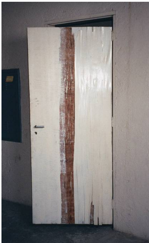
Foto 19: Vista de uma porta em madeira deteriorada, sem pintura.
