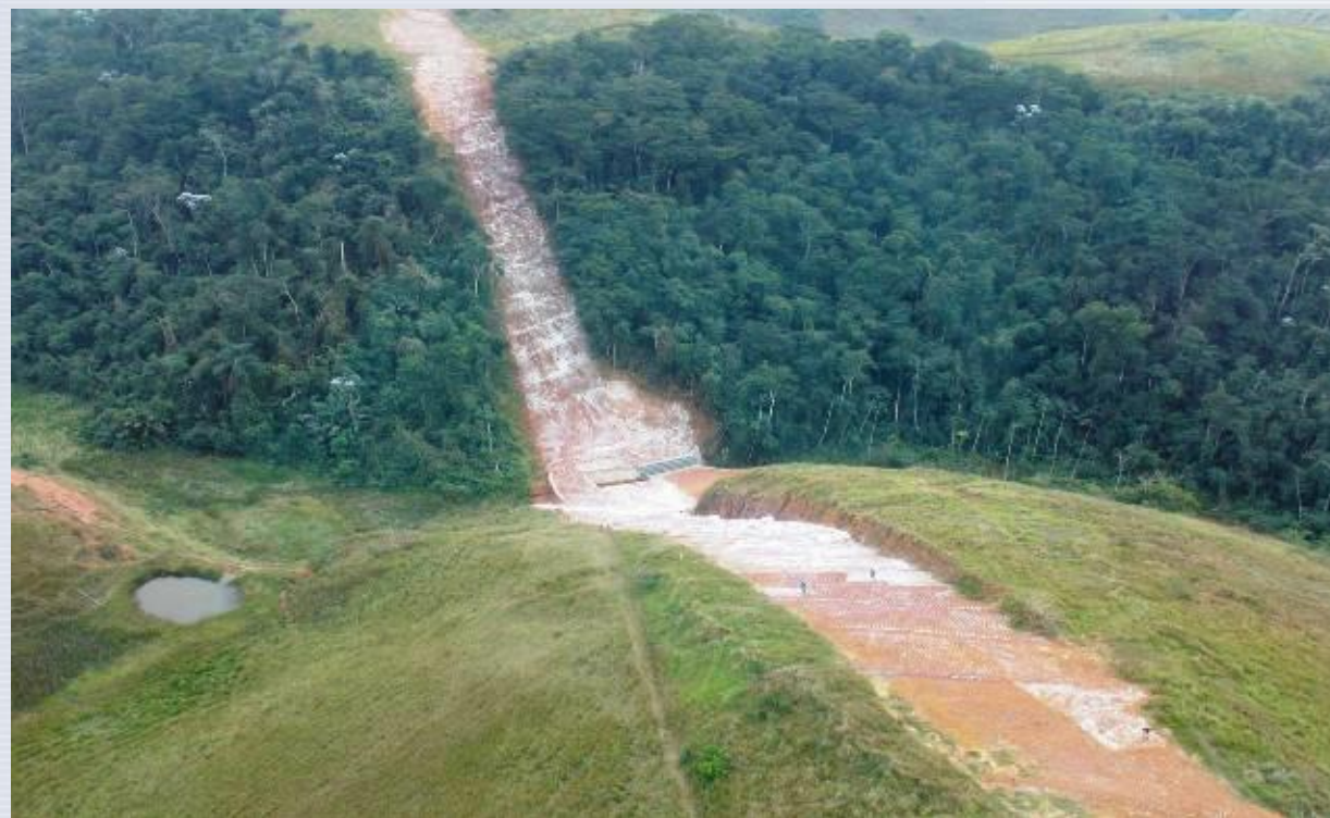
Abertura de Pista
