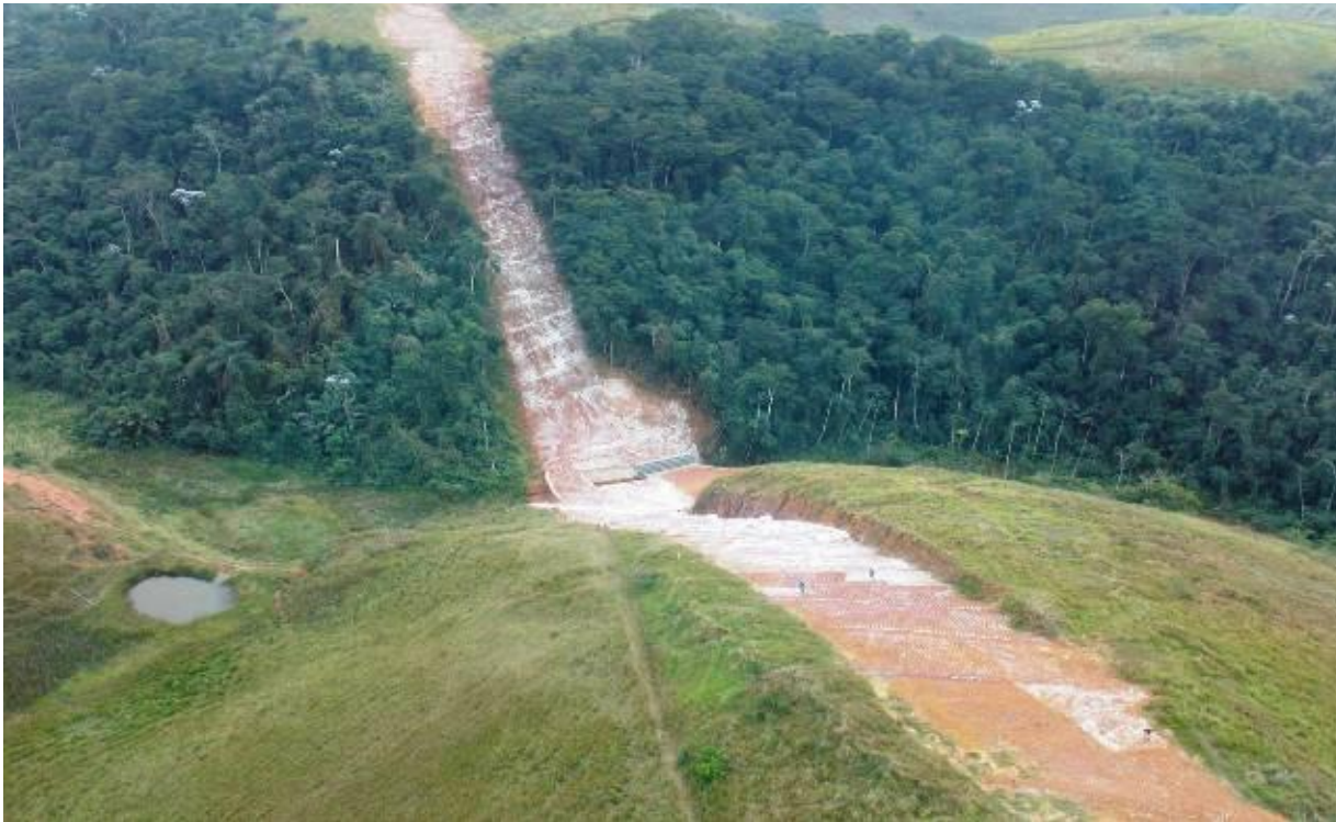
Abertura de Pista
