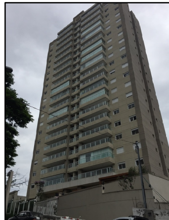
Fig 8: Edifício de padrão construtivo superior.
