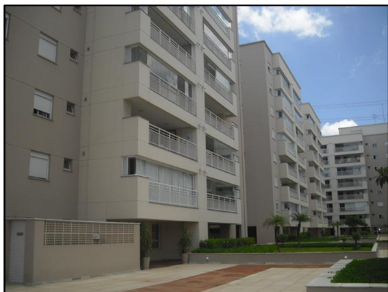
Fig. 1: Edifício de padrão construtivo médio.
