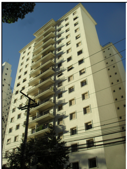
Fig. 5: Edifício de padrão construtivo superior.
