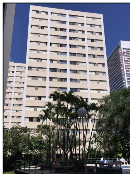
Fig. 4: Edifício de padrão construtivo médio.
