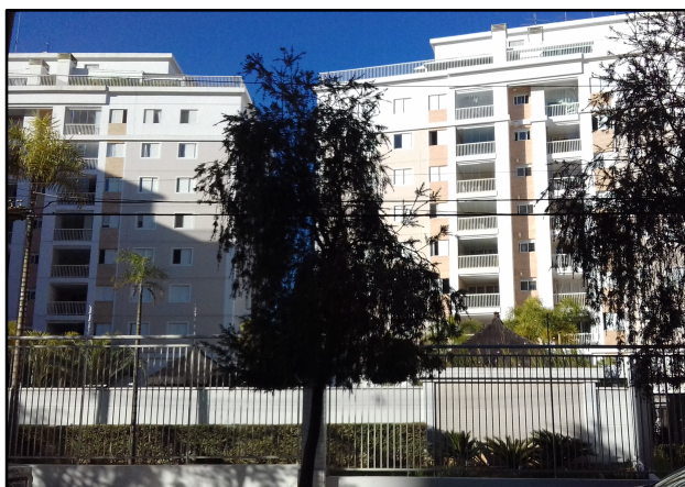
Fig 7: Edifício de padrão construtivo superior.
