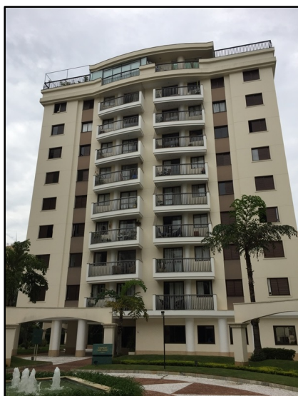
Fig. 3: Edifício de padrão construtivo médio.
