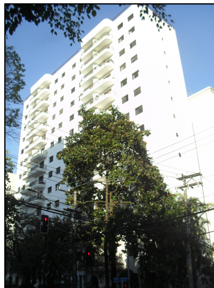
Fig. 6: Edifício de padrão construtivo superior.
