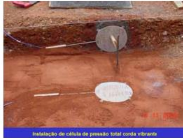
Instalação de célula de pressão total corda vibrante
