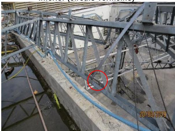
**Figura 19 – Detalhe da emenda da Figura 18. Observar solda deficiente, com uso de “tarugos” de aço**
