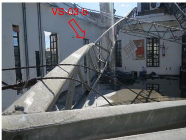
**Figura 7 – Vista da peça central superior com destaque para o rompimento da ligação entre a viga principal e a peça (setas vermelhas)**
