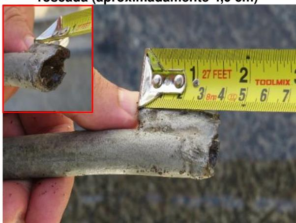
**Figura 34 – Suporte da barra rosca na chapa da VP-01 (no lado norte, Detalhe 12 do projeto)**
