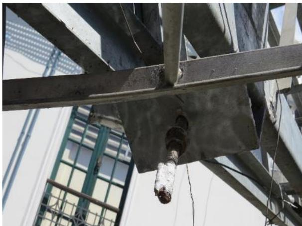
**Figura 35 – Detalhe da Figura anterior, com destaque para o local de ruptura do tirante com a barra rosca (em processo avançado de corrosão)**
