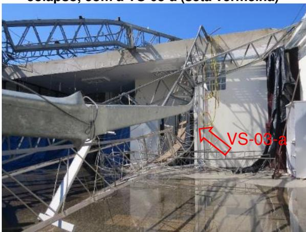
**Figura 6 – Vista parcial da estrutura metálica que sofreu o colapso**
