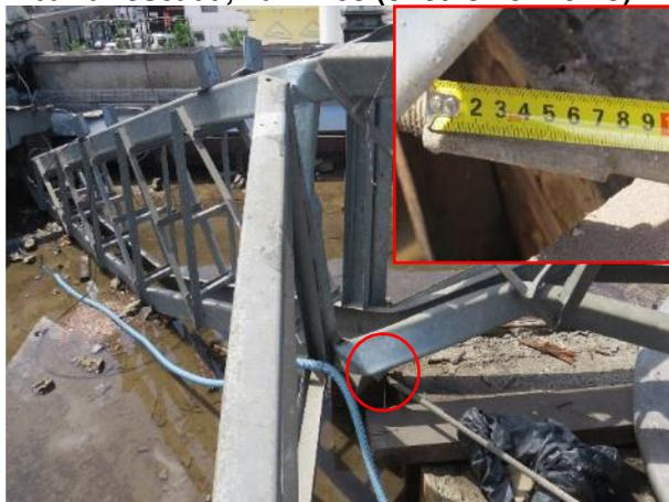
**Figura 39 – Detalhe da solda do tirante com a barra rosca, na VP-02 (círculo vermelho)**
