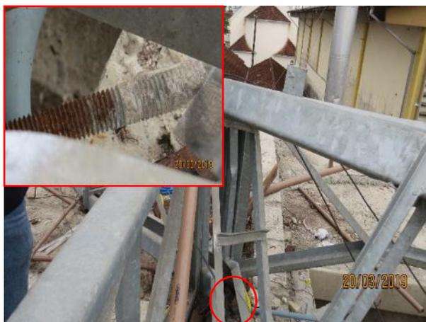
**Figura 42 – Emenda do tirante da VP-01 e VP-02 (círculo vermelho)**
