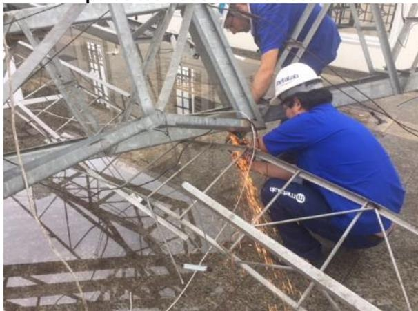
**Figura 52 – Retirada de amostras para ensaio pelos técnicos do Laboratório**
