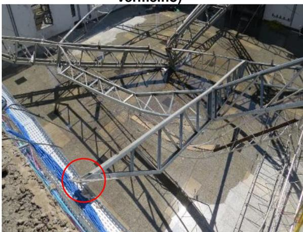
**Figura 26 – Chapa de fixação da VP-01 (Detalhe 02, do projeto) ainda com parabolts (círculo vermelho)**
