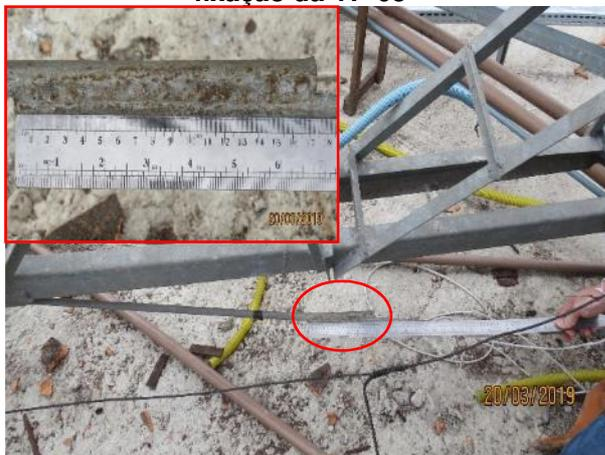
**Figura 41 – Detalhe da solda do tirante com a barra rosca, na VP-03 (círculo vermelho)**
