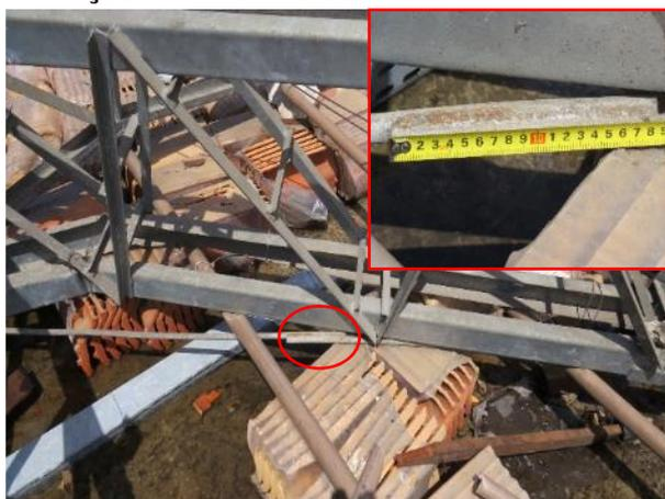
**Figura 37 – Detalhe da barra rosca da VP-01 (lado norte), com medida de solda de aproximadamente 4,0 cm**
