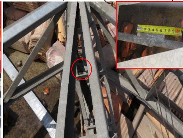
**Figura 40 – Emenda do tirante da VP-03 e VP-04 (círculo vermelho), próxima ao ponto de fixação da VP-03**
