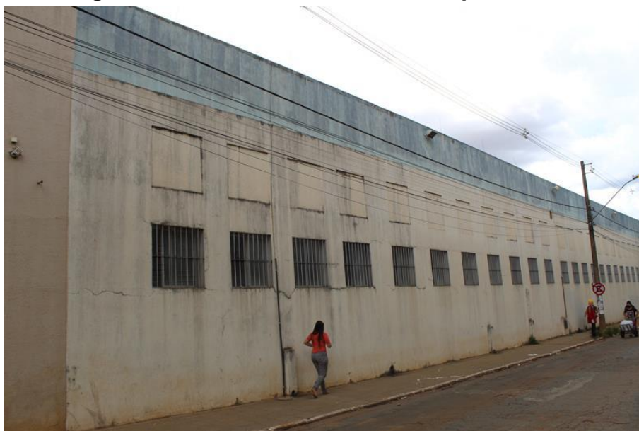
Figura 1 – Vista lateral do imóvel inspecionado.
