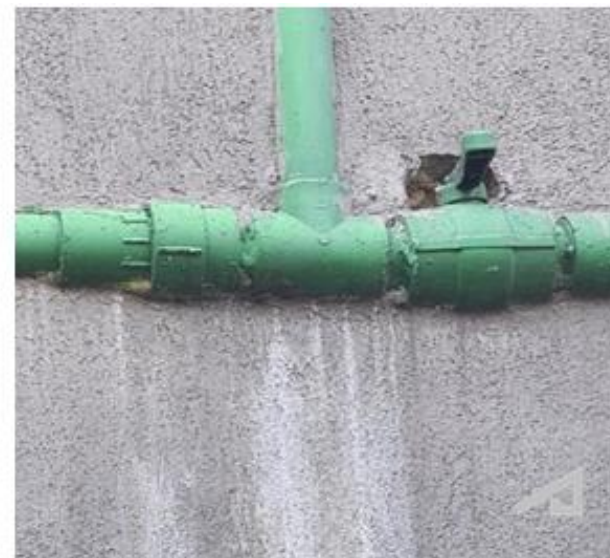
Tubulações aparentes reservatório superior, situação após execução de obras de revestimento externo
