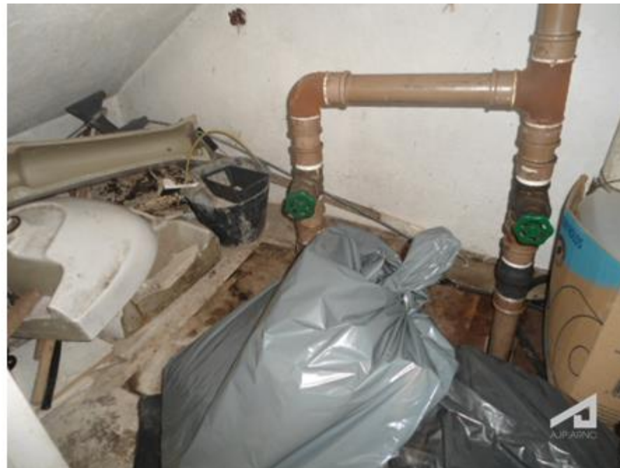
Acesso reservatório inferior
