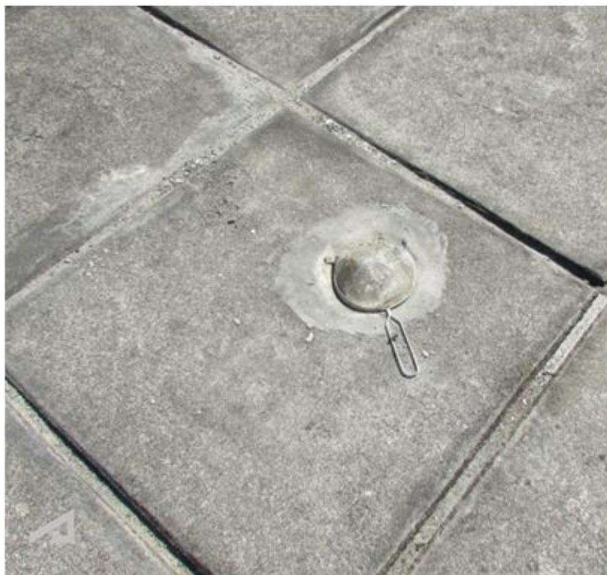
Pavimentos de telhado: pontos de escoamento de águas pluviais
