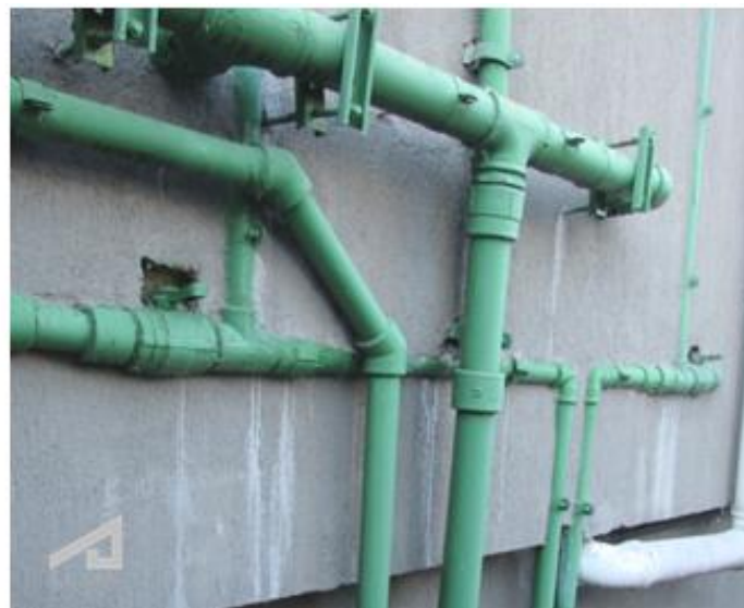
Tubulações aparentes reservatório superior, situação após execução de obras de revestimento externo
