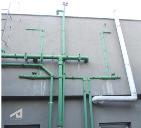
Tubulações aparentes reservatório superior, situação após execução de obras de revestimento externo
