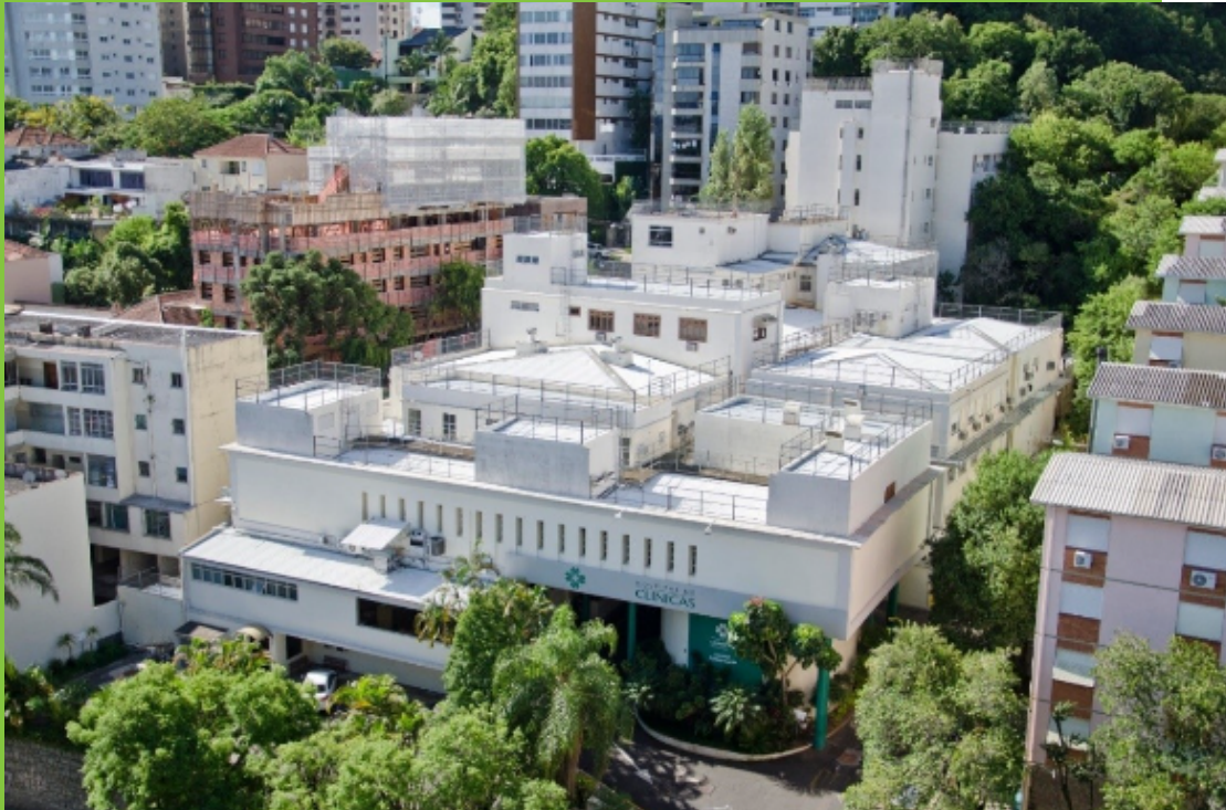
Figura 1 - Frente do imóvel
