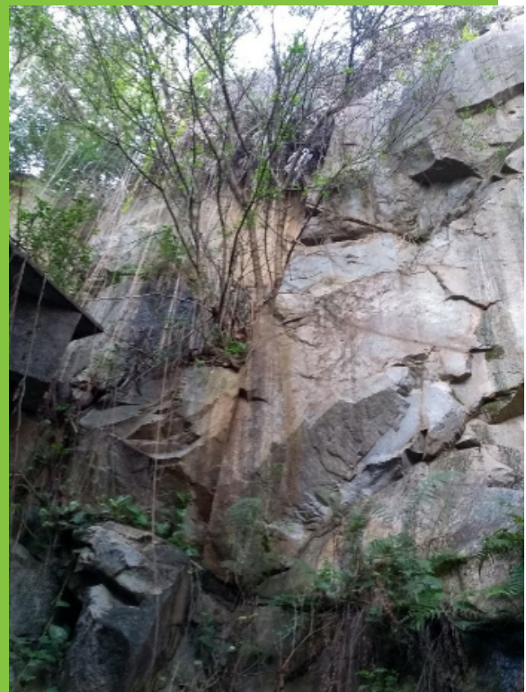
Figura 6 - Paredões rochosos presentes no imóvel - fraturamento do maciço
