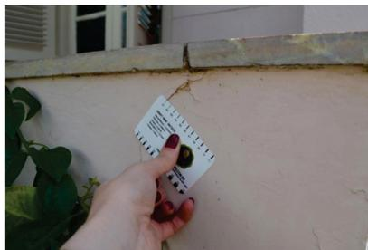
Figura 3: Constatação da espessura
