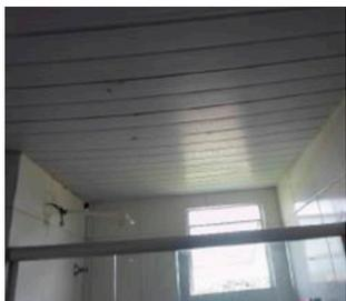
**Exemplo 4:** Alegação de vazamento em sistema de esgoto, cuja constatação é precarizada ou impedida sem a remoção de forro de PVC.
