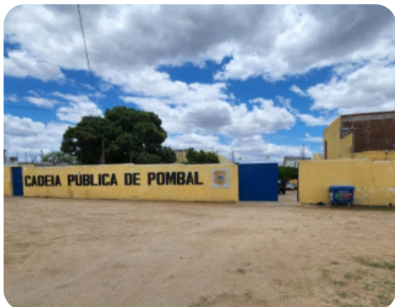
Foto 15. Tomada geral da entrada da unidade (Cadeia Pública de Pombal).
