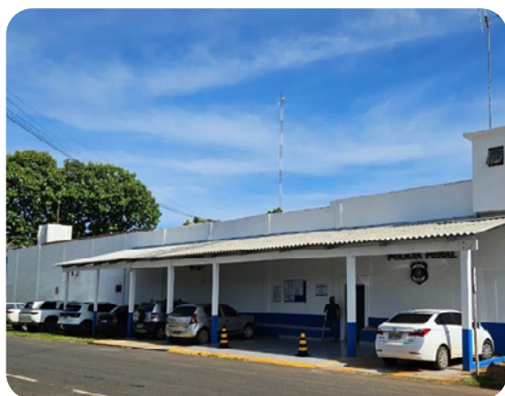
Foto 55. Tomada geral da entrada da unidade (Casa de Detenção de Vilhena).
