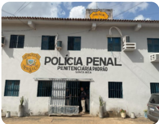
Foto 11. Tomada geral da entrada da unidade (Penitenciária Padrão de Santa Rita).
