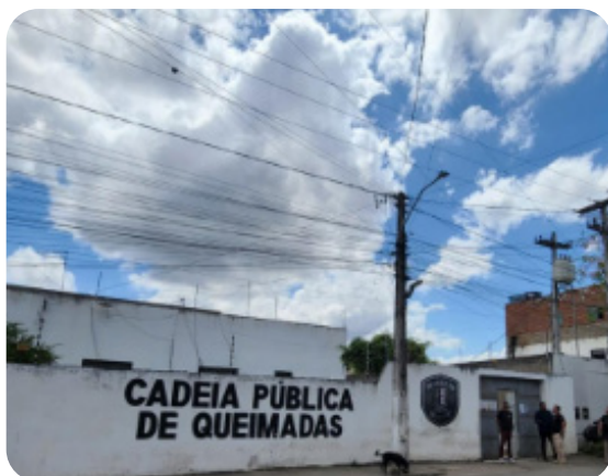
Foto 17. Tomada geral da entrada da unidade (Cadeia Pública de Queimadas).
