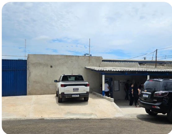
Foto 57. Tomada geral da entrada da unidade (Casa de Prisão Albergue de Jarú).
