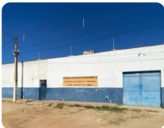
Foto 43. Tomada geral da entrada da unidade (Cadeia Pública de Tabira).
